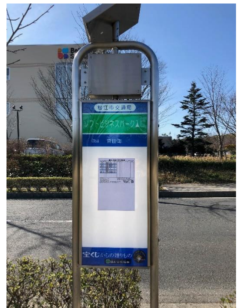
令和5年度に設置したソーラー照明付き標識 ソフトビジネスパーク入口(松江市)
